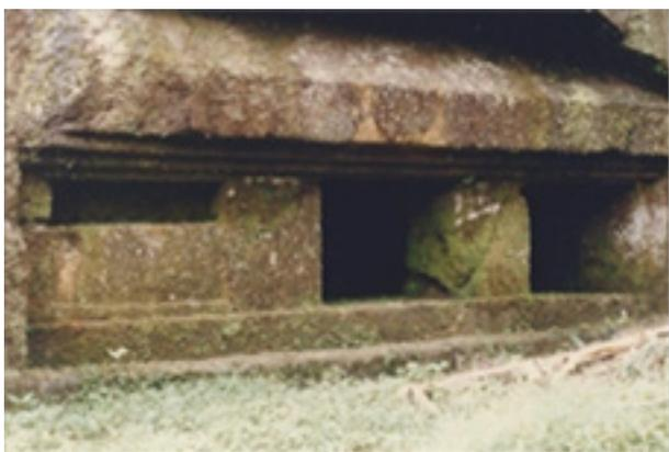
**Gambar 5.** Bangunan bertiang delapan (*sakatus*) satu bilik tertutup dengan satu lubang pintu dan dua lubang jendela.
